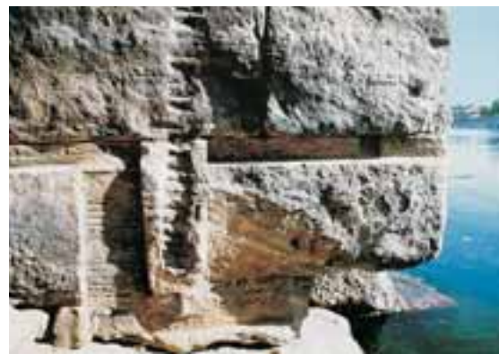
Grazie a questa scala graduata incisa nella roccia gli antichi egizi potevano rendersi conto del livello raggiunto dalle piene del Nilo e prevedere la quantità di raccolto che avrebbero ottenuto.
