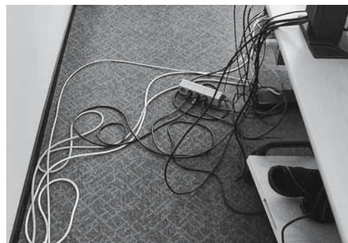
Fig. 4: Disporre le prese di corrente in modo tale da non creare un pericolo di inciampare.
