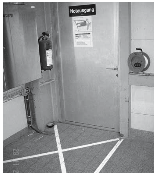
Fig. 3: Tenere libere le vie di fuga.
